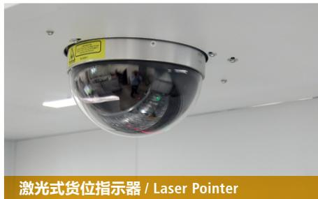
激光式货位指示器 / Laser Pointer
